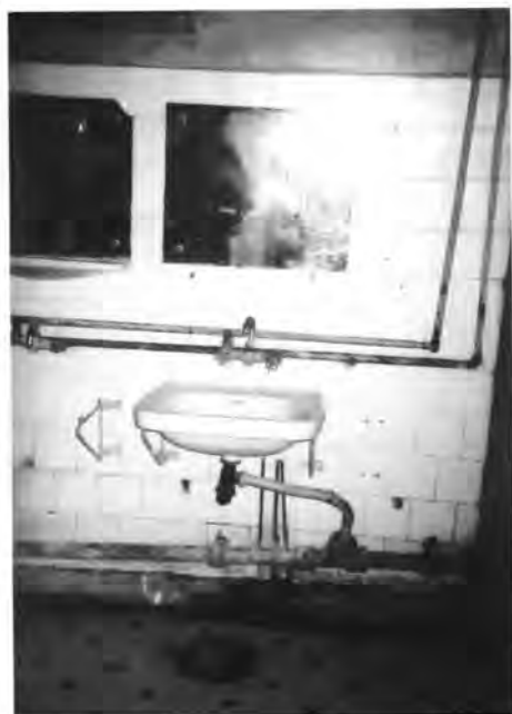
Krankenhaus in Iasi 2001, Waschraum
